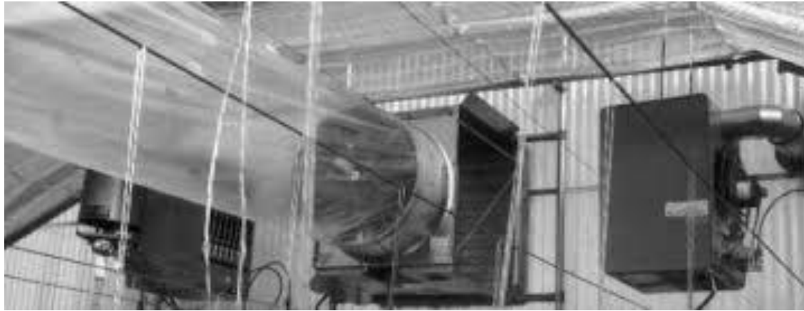
Fan Jet system with heater 多功能系統 加熱/強制通風/內循環
