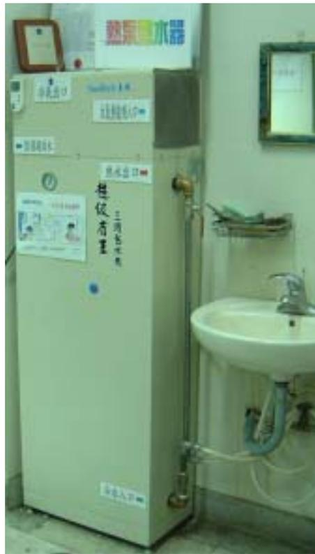
圖 4 小型熱泵熱水器(NC120)
