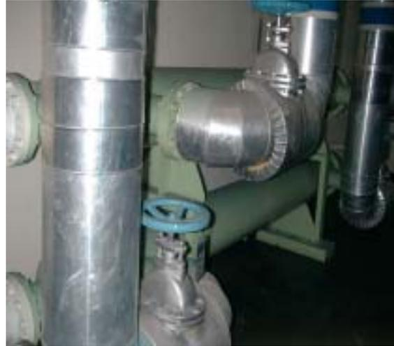
圖 12 冷卻水熱交換器
