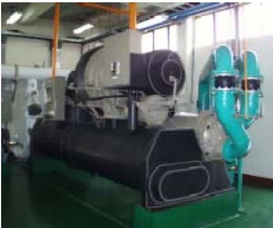
圖 3 導入 500RT 高效率冰水主機
