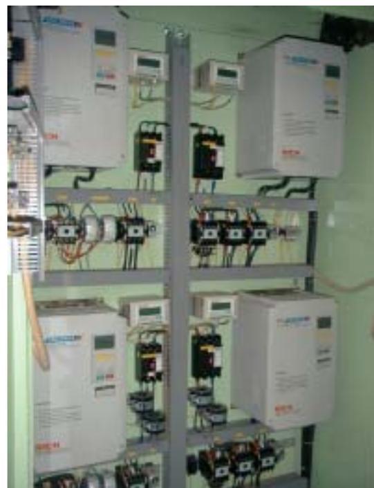
圖 14 冰水區域泵加裝變頻控制器
