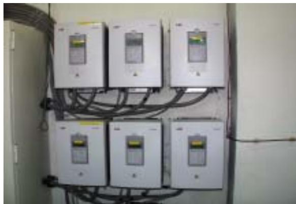
圖 5 冰水泵及冷卻水風扇變頻控制
