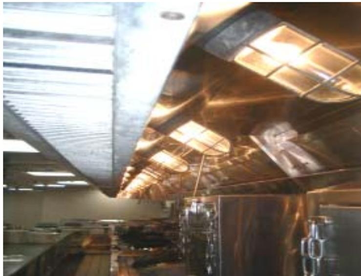
圖 15 廚房煙罩提供外氣，以補足煙罩排氣量，減少冷氣流失。
