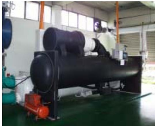
圖 4 使用 1000RT 高效率冰水主機
