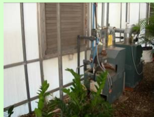
觀葉作物溫室內的地底加熱系統
