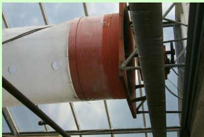
塑膠軟管連接強制送風加熱器
