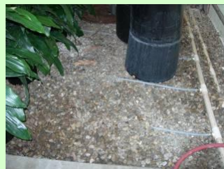
觀葉作物溫室內的地底加熱系統
