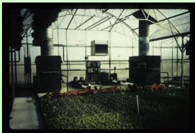
花壇作物溫室內的地底加熱系統
