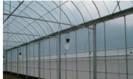
圖 1b. 溫室 Y，立柱式鉸管溫室
